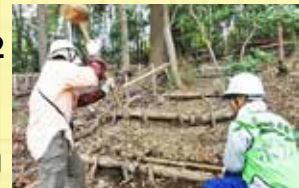
中央通路階段補修杭打ち
