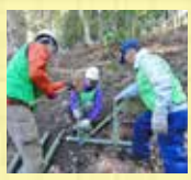
中央斜面地土留め
