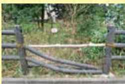
第3緑地柵修復
