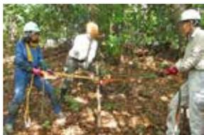
↑クイを打ち込むときの安全確保のためスリングを使用。
