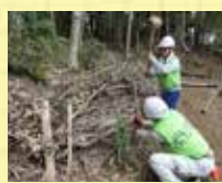
コンポスト柵補修杭打ち
