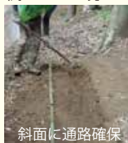
斜面に通路確保
