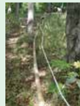
ロープ柵設置
