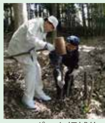
コンポスト柵補修
