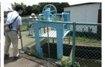
水門：大水のとき佐須用水を下水へ流すために設置されている。
