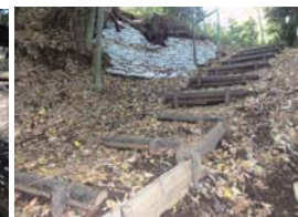
補強された階段
