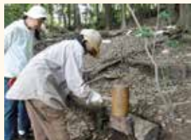
階段補修杭打ち
